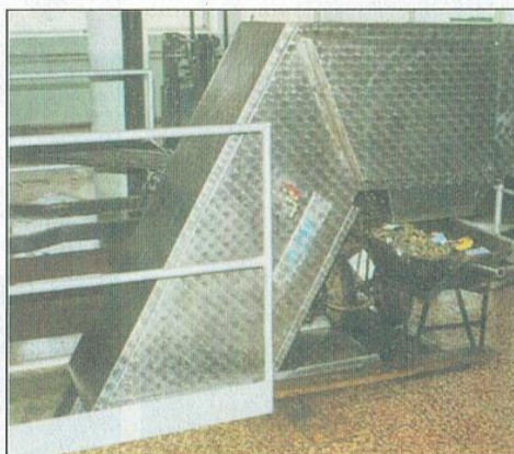
Griglia meccanica autopulente (Isipa)
