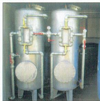
Unità di trattamento Tipo A (Isipa)
